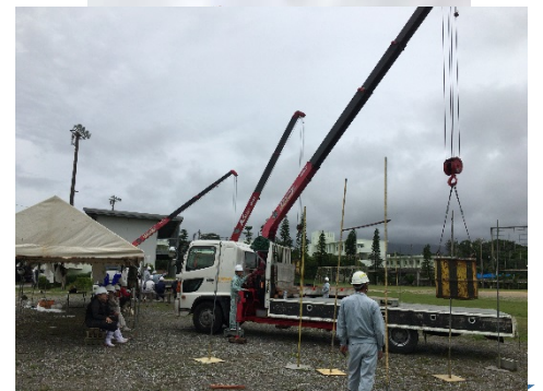
小型移動式クレーン
