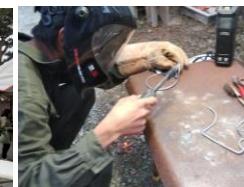
アーク溶接(農業機械)
