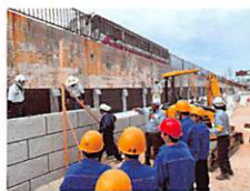
建設現場視察
